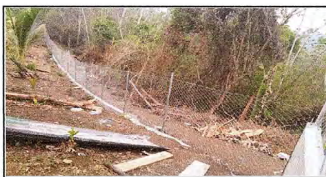
Foto 5: Así quedo el muro perimetral de la parte de atrás de la escuela
